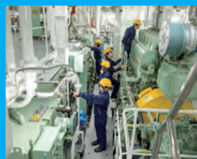
鳥羽丸機関室点検中
