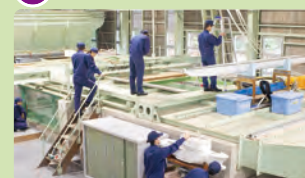
⑩ 荒天航泊実験棟
