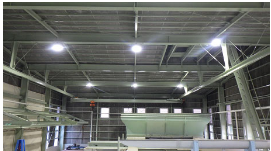
建屋内部（照明のLED化）
