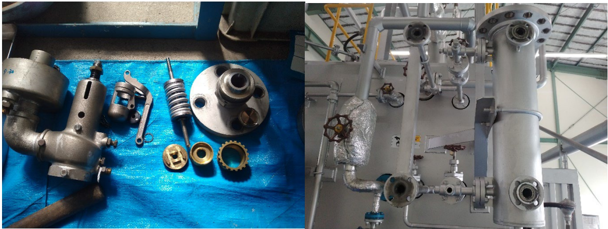
ボイラー整備の様子
