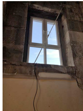
図4 簡易的に設置したアンテナ
