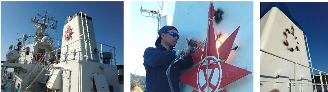
図1 校章溶断の様子
