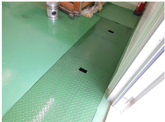
図 1 第一内燃機関室北側入口付近側溝の蓋作製
