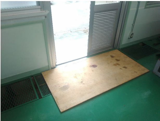
図 1 第一内燃機関室北側入口付近側溝の蓋作製
