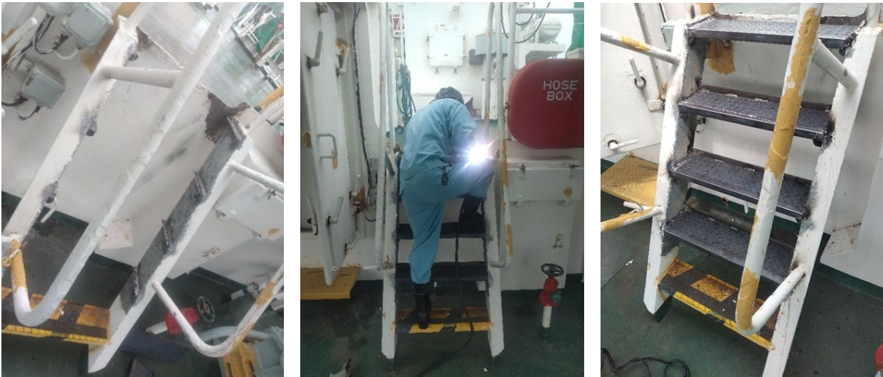
図 1 鳥羽丸階段修理（外注による見積合計金額 630,000 円）
