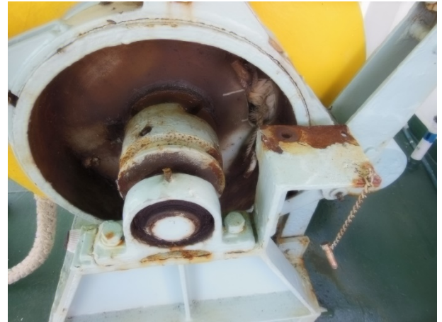
図1 鳥羽丸ホーサーリール修理
