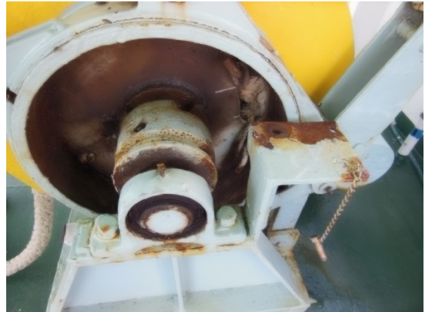
図1 鳥羽丸ホーサーリール修理
