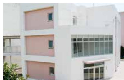
4号館（校舎） No.4 Building
