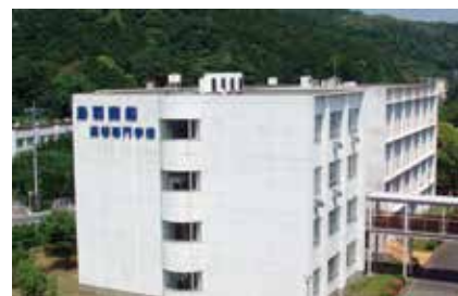
3号館（校舎） No.3 Building
